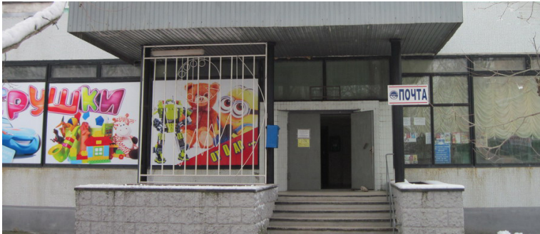
Рис. 1. Существующее здание узла связи в г. Днепропетровск
