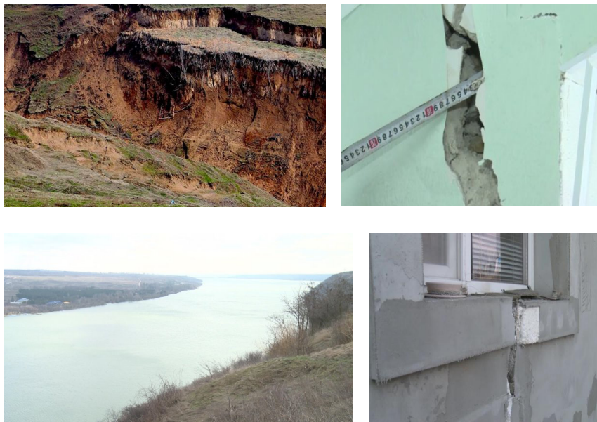
Рис. 1. Оползень с. Маркауцы, Дубоссарского р-на
