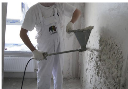
Рис. 2. Нанесение штукатурной смеси с помощью хоппер-ковша
