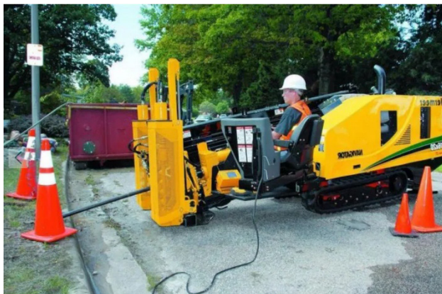
Рис. 1. Прокладка коммуникаций под дорогой методом управляемого прокола
