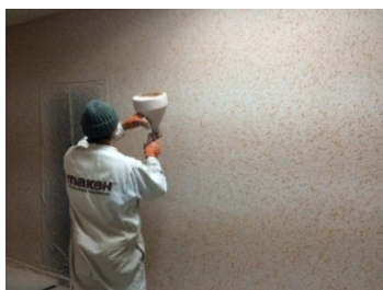
Рис. 1. Использование картушного пистолета для напыления декоративной штукатурки
