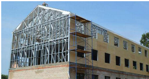
Рис. 1. Реконструкция здания методом надстройки с использованием ЛСТК
